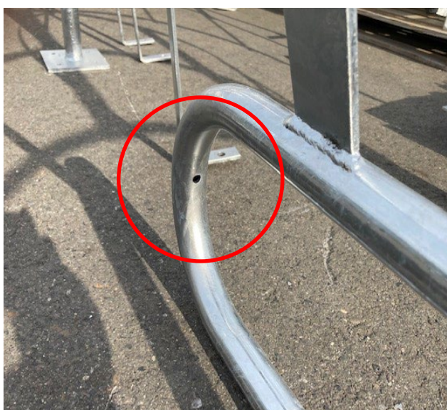
R曲部に空気抜き孔
